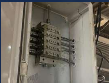
Progresívny rozdeľovací blok
