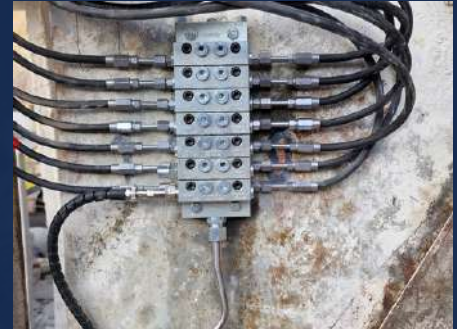
Progresívny rozdeľovací blok
