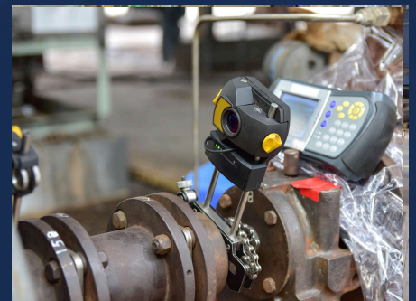
Ustavenie elektromotora a čerpadla
